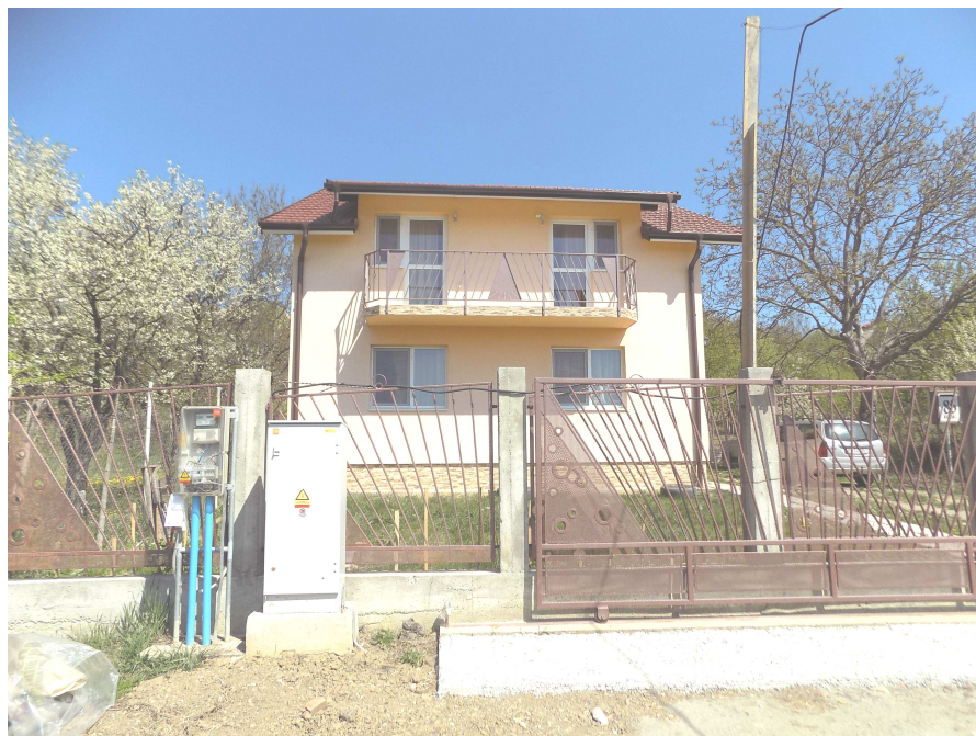
Construcție existentă la nr. 85
