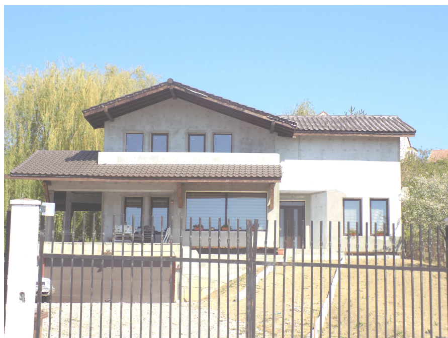
Construcție existentă la nr. 81
