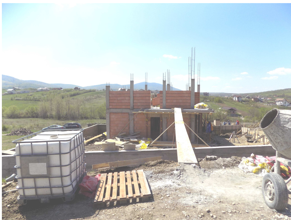
Construcție nr. 2 autorizată în curs de execuție
