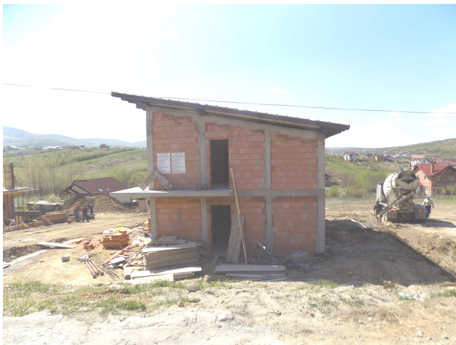
Construcție nr. 1 autorizată în curs de execuție
