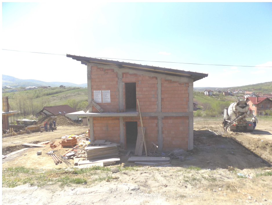
Construcția nr. 1 existentă
