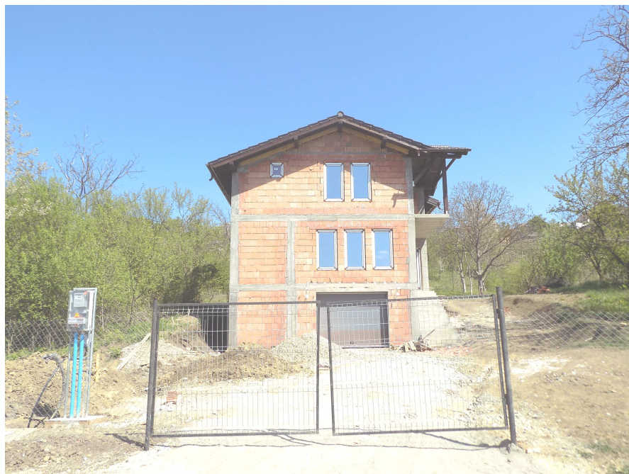
Construcție existentă la nr. 87
