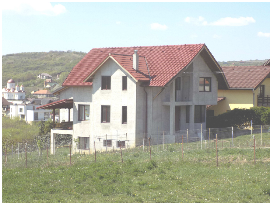
Construcție existentă la nr. 68
