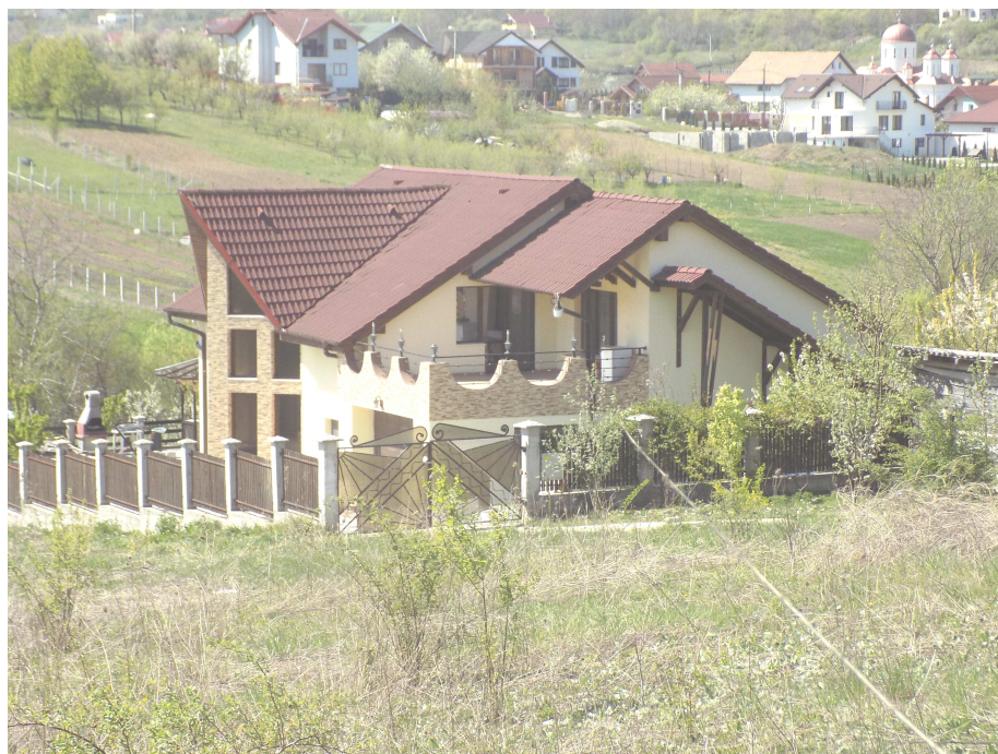
Construcție învecinată existentă la nr. 76
