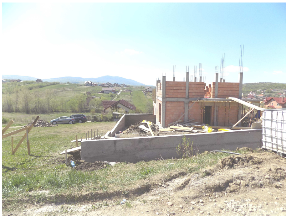
Construcția nr 2 existentă
