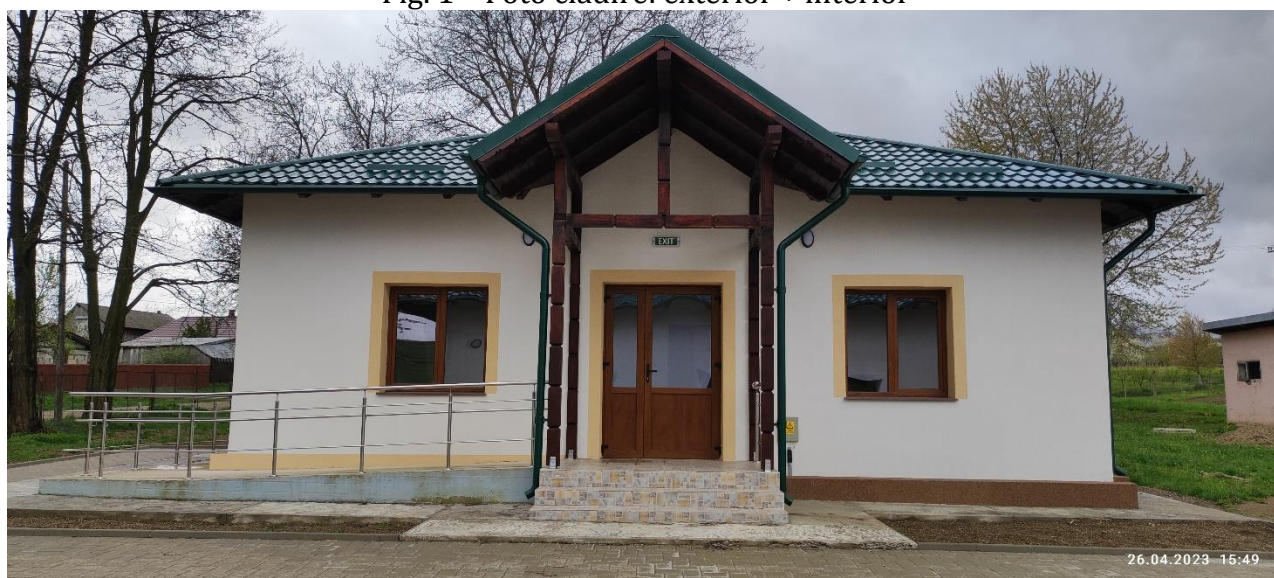
Fig. 1 – Foto clădire: exterior + interior
