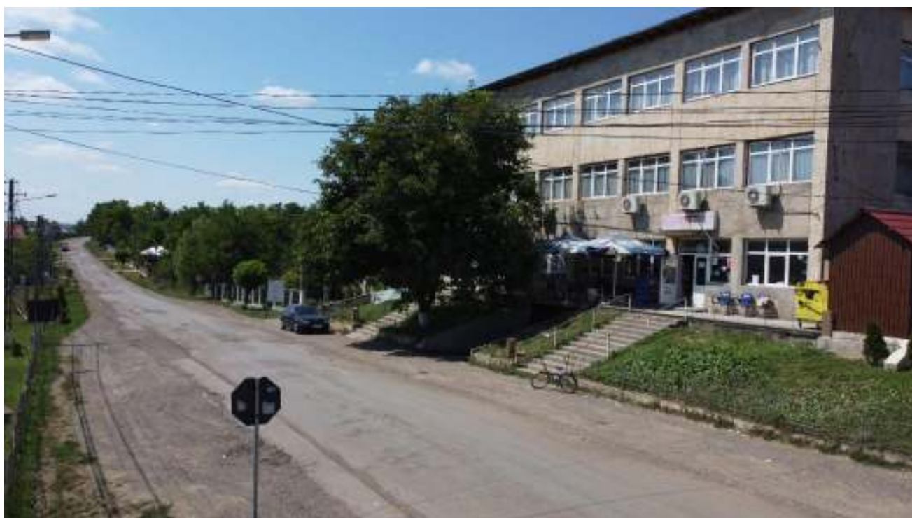
Figura 9. Clădirea fostei cooperative de consum din Todireni
