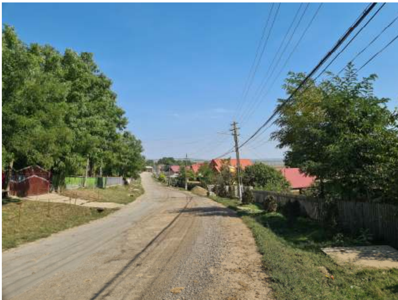
Figura 15. Drumul județean, în faza lucrărilor de modernizare
