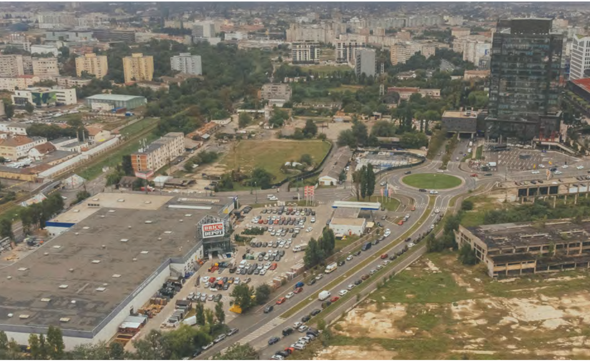
Vedere aeriană dinspre intersecția străzilor Aristide Demetriade și Bulevardul Antenei Se observă terenurile dezafectate situate în lungul Bulevardului Antenei și adiacent străzii Aristide Demetriade, aflate în proprietatea SC TIMCON SA.
