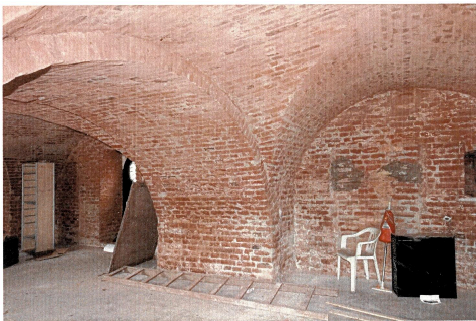
Fig. 15 – Peretele nord-vestic (zidul de fortificație), cu vizibilitate către efectele ascensiunii capilare a apei.
