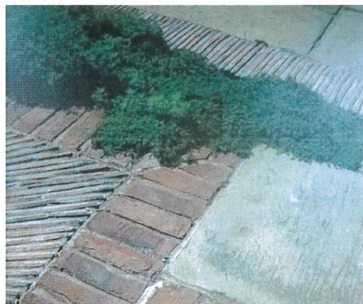
Alee din cărămidă, lespezi, plăci de piatră și vegetație
