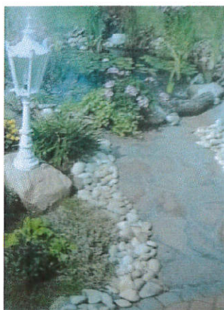
Opus incertum cu rosturi: pline, din mușchi și din pietriș
