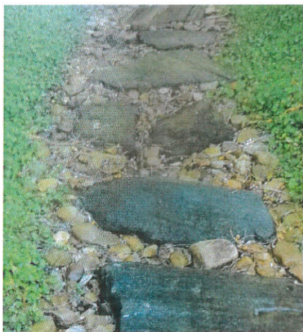
Alee pietriș și lespezi din piatră naturală sau prefabricate
