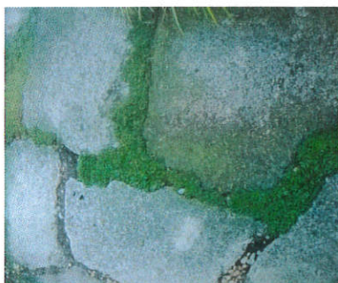
Opus incertum cu rosturi: pline, din mușchi și din pietriș
