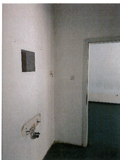
Lavar lipsa zona foaier, calorifer eliminat zona foaier, paturi de cablu eliminate zona statie ventilatie
