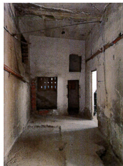
Lavar lipsa zona foaier, calorifer eliminat zona foaier, paturi de cablu eliminate zona statie ventilatie
