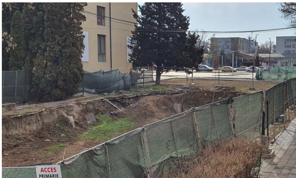
Fig.10 - Vedere dinspre strada Episcopiei cu excavatia inceputa pentru accesul auto in subsol
