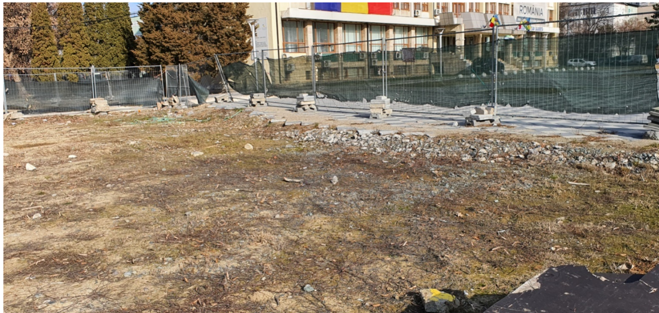
Fig. 7 – Zona in care sunt neccsare lucrari de completare a straturilor si finisajelor de peste planseul parcarii subterane si in imediata vecinatate a acestuia pana la limita de proprietate a obiectului de investitii
