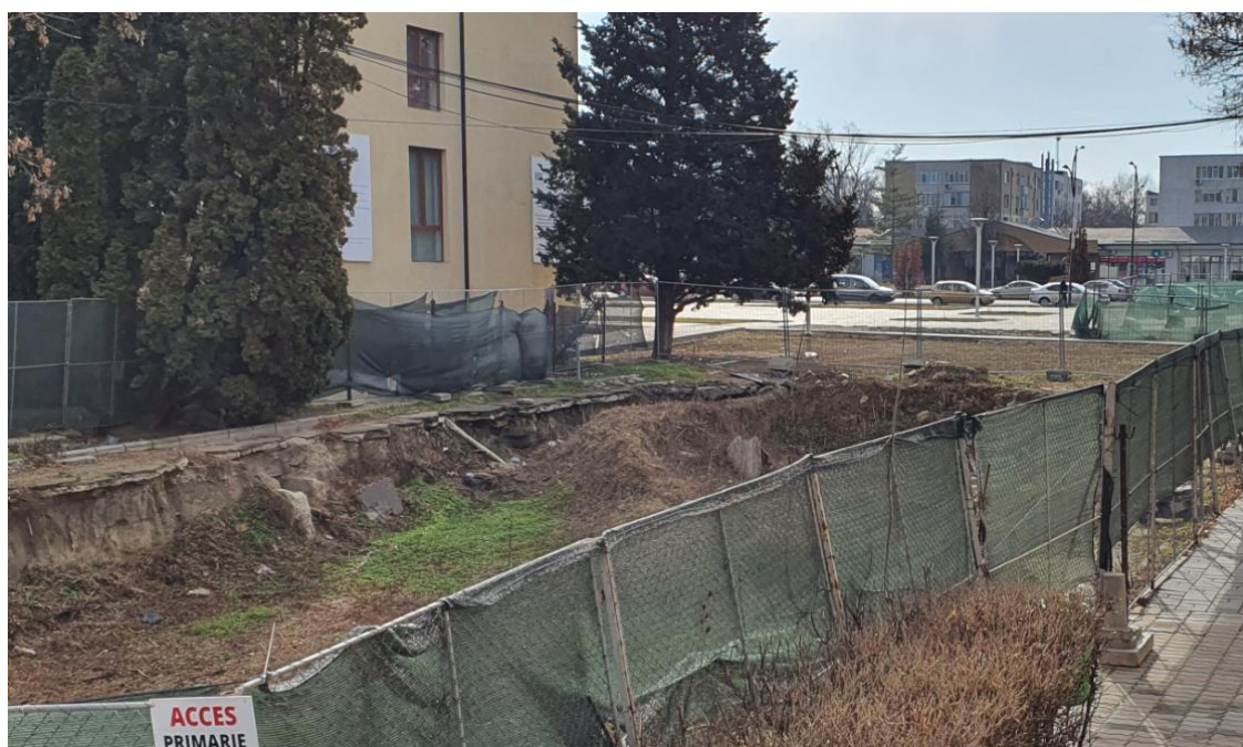
Fig. 18 - Vedere dinspre strada Episcopiei cu excavatia inceputa pentru accesul auto in subsol
