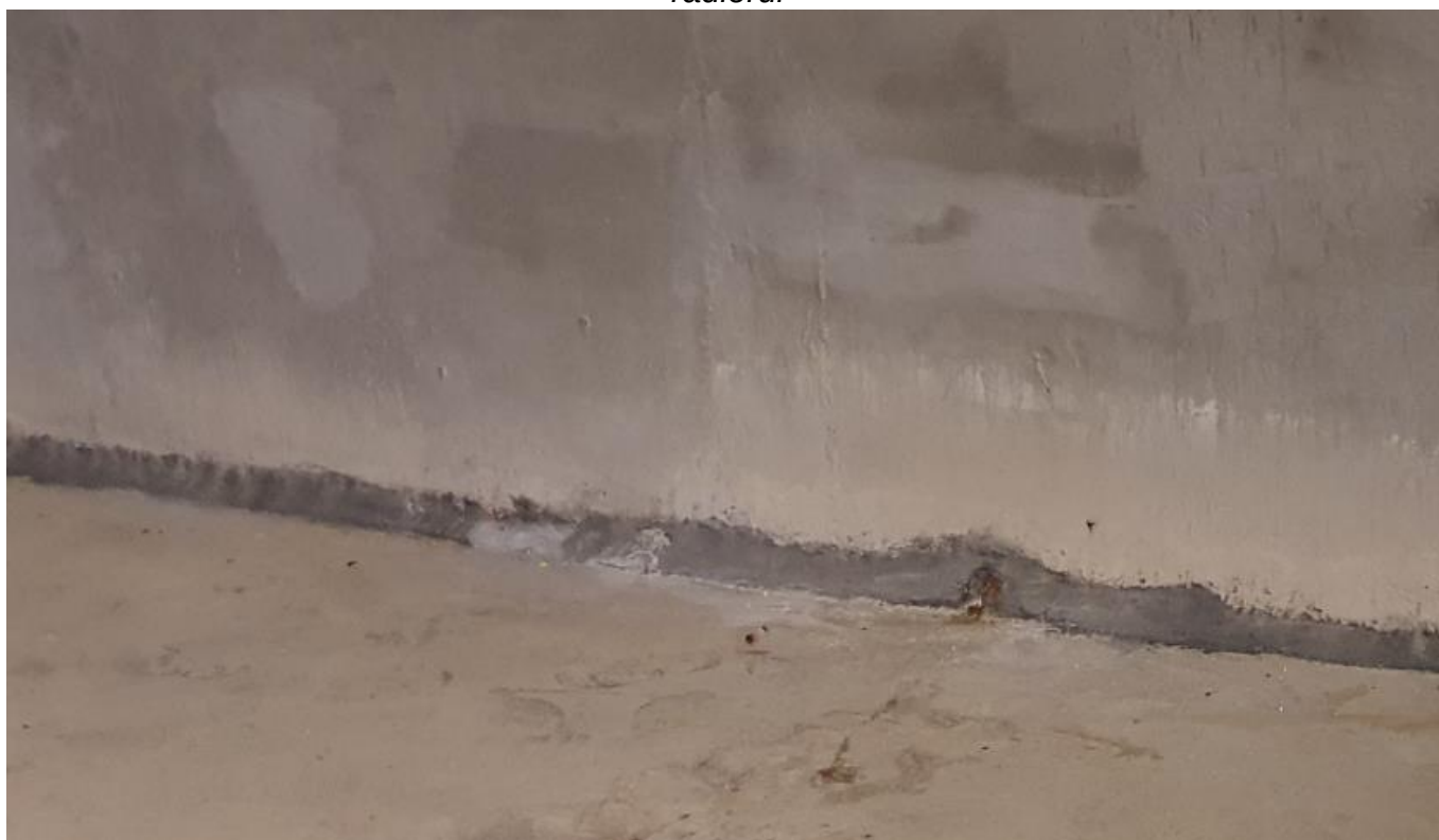
Fig. 9 – Reparatii locale ale rostului de turnare dintre peretele perimetral si radier, prin utilizarea unui mortar impermeabil
