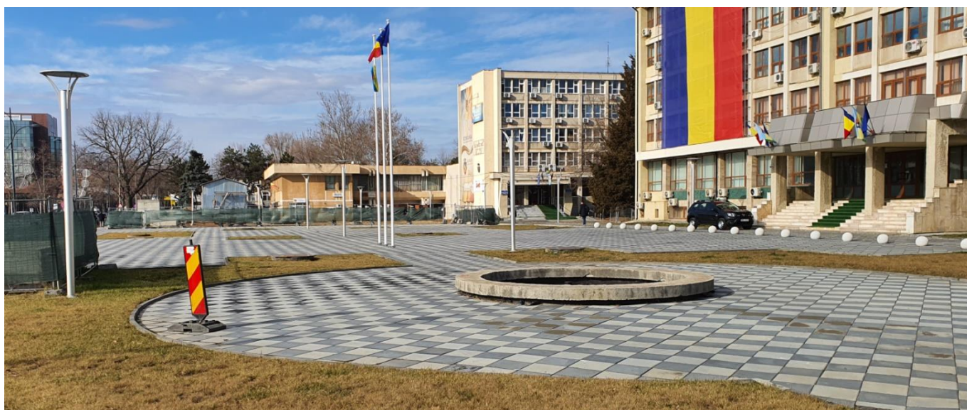
Fig. 16 - Zona de peste parcare subterana – Vedere dinspre Bvd. Chimiei
