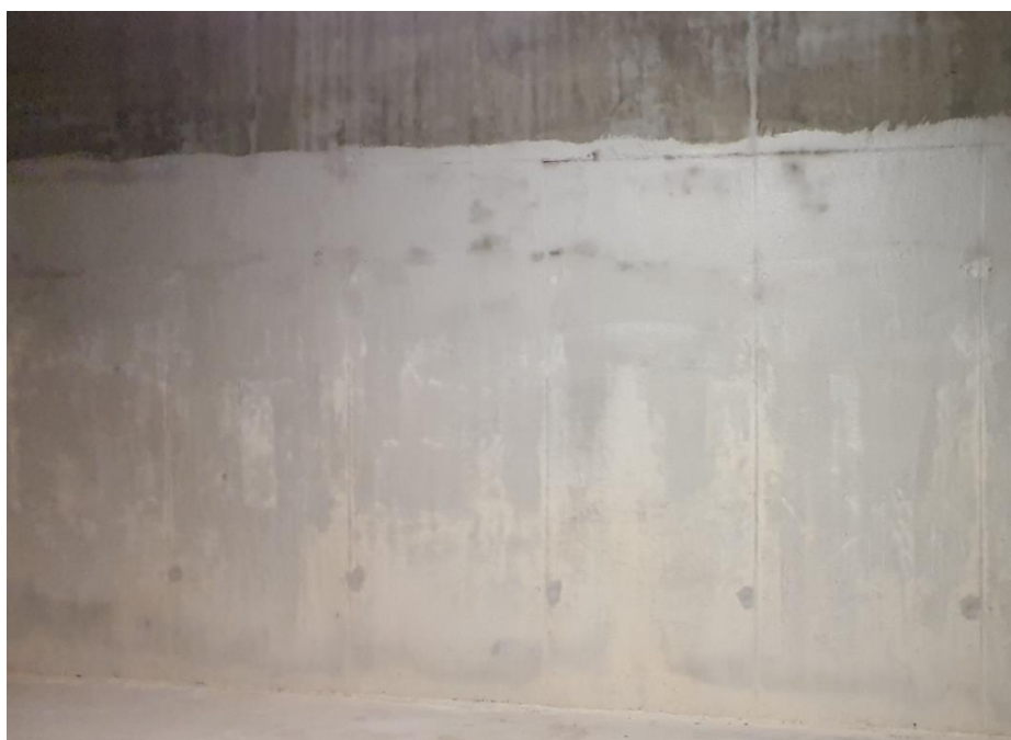
Fig. 14 – Protejare elemente structurale parcare prin intermediul unor tencuieli realizate din mortare impermeabile
