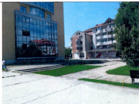
Pe latura din spatele a zonei studiate , spre clădirea cu perete cortina apare un pavaj din pavele autoblocante.
