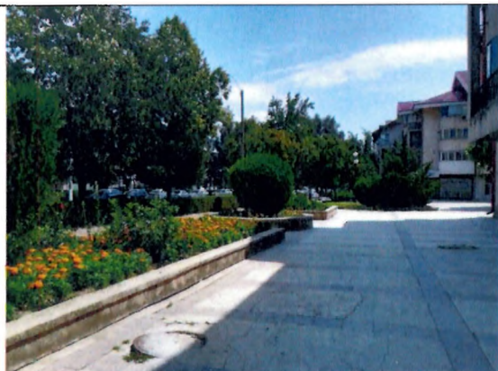
Zona vecina cu B-dul matei basarab. Suprafata carosabila cu beton de ciment mozaicat , denivelat , cu crapaturi multiple , canalizare dislocata.
