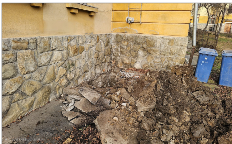
Foto 3. Aspectul terenului investigat în zona dezvelirii D-1
