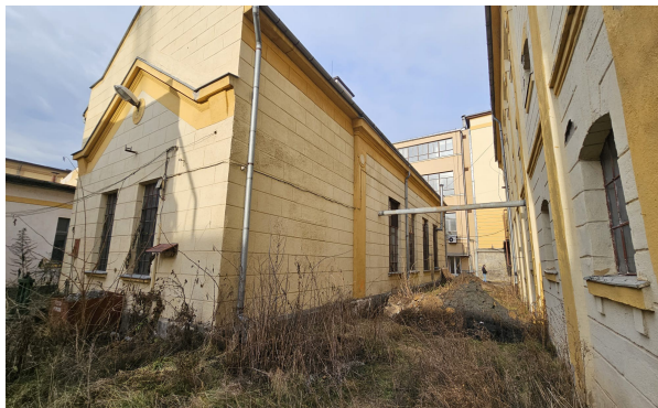
Foto 13. Aspectul terenului investigat în zona dezvelirii D-5
