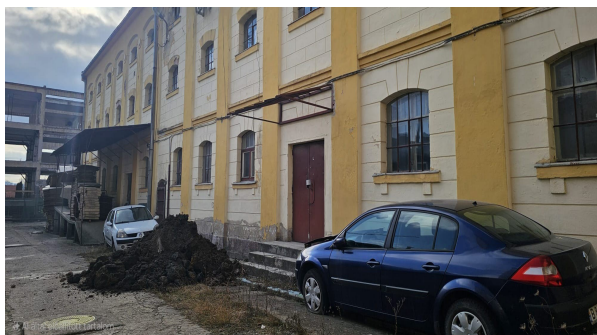
Foto 20. Aspectul terenului investigat în zona dezvelirii D-9
