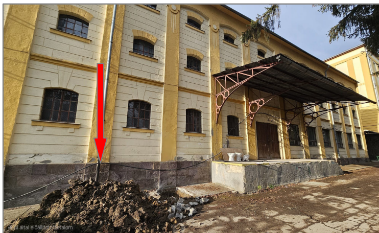
Foto 8. Aspectul terenului investigat în zona dezvelirii D-3
