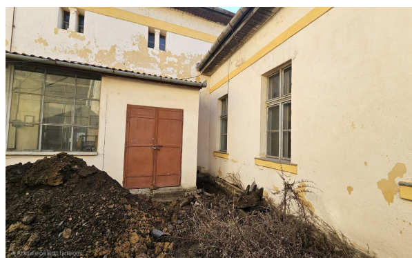
Foto 17. Aspectul terenului investigat în zona dezvelirii D-7
