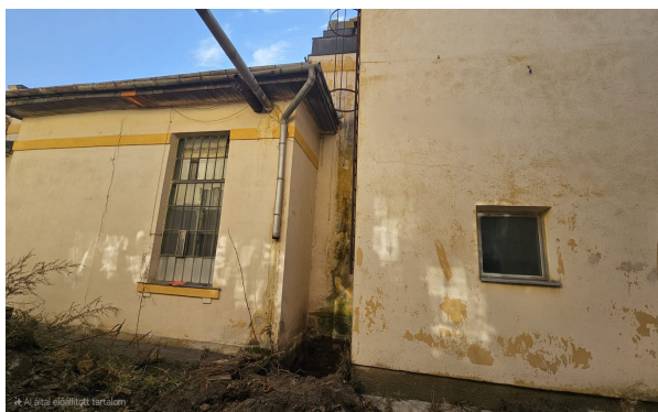
Foto 15. Aspectul terenului investigat în zona dezvelirii D-6
