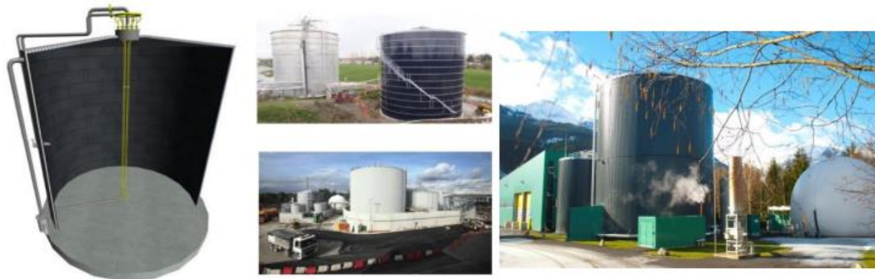
Figură 3-66 Exemple de digestoare verticale în lichid
