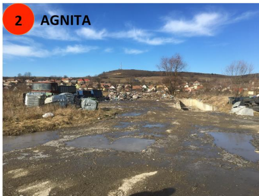
Figură 2-15 - Stația de transfer Agnita
