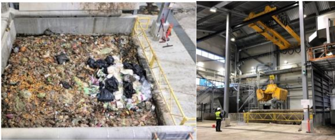
Figură 3-63 Groapa tehnologică de stocare și podul rulant cu greifer
