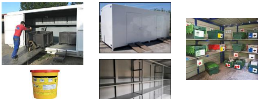
Figură 3-40 CAV – exemple containere deșeuri
