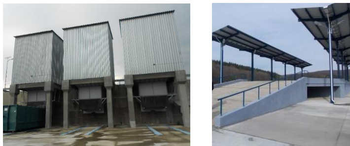
Figură 3-4 – Stație de transfer (exemple)
