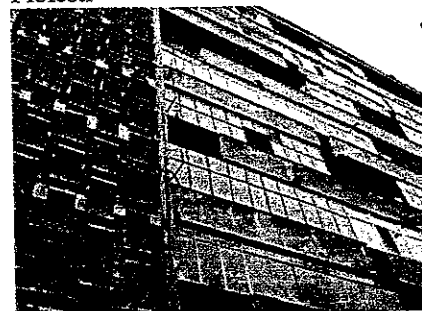
Vedere exterioara bloc 15, sc A, parter ap .4, Str. Scorusului nr. 2, Ploiesti
