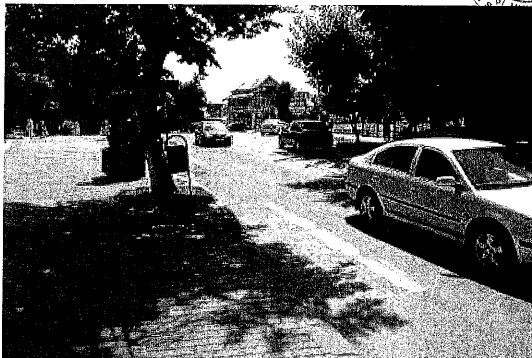
Foto.2 Intersecție str. Stefan cel Mare - str. Grădiniței - vedere sensul de deplasare dinspre Tribunal
