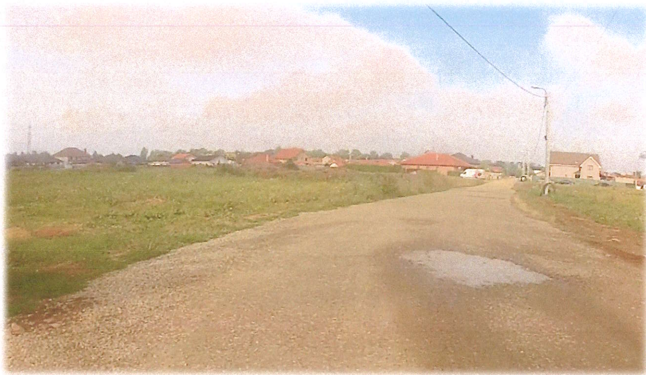
Foto 1 (strada Pavilioanele CFR principala: Vedere din strada Plantelor)
