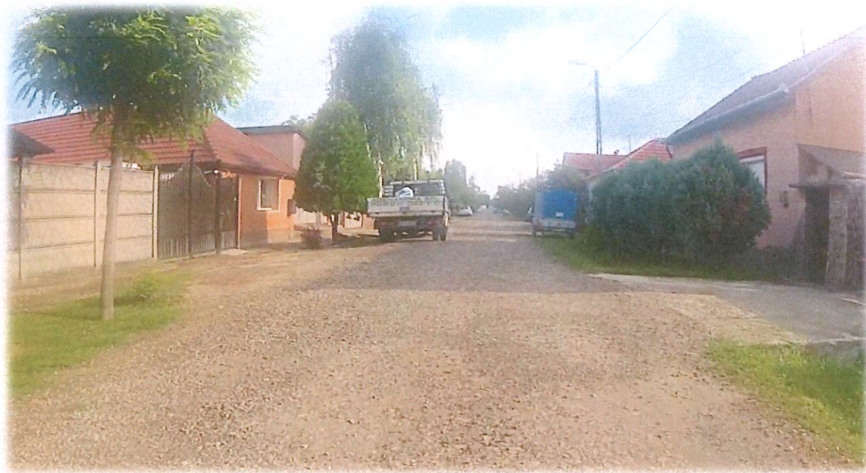
Foto 2 (Vedere din strada Cornului)
