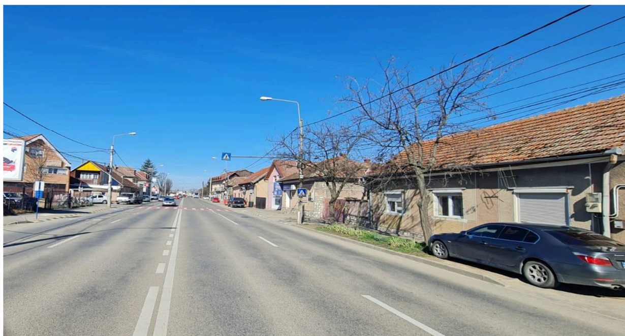
Fig.12. – Zona 3 - Intersectia 2 - Trecere de pietoni cu buton pietonal – Calea Clujului – strada Aiudului
