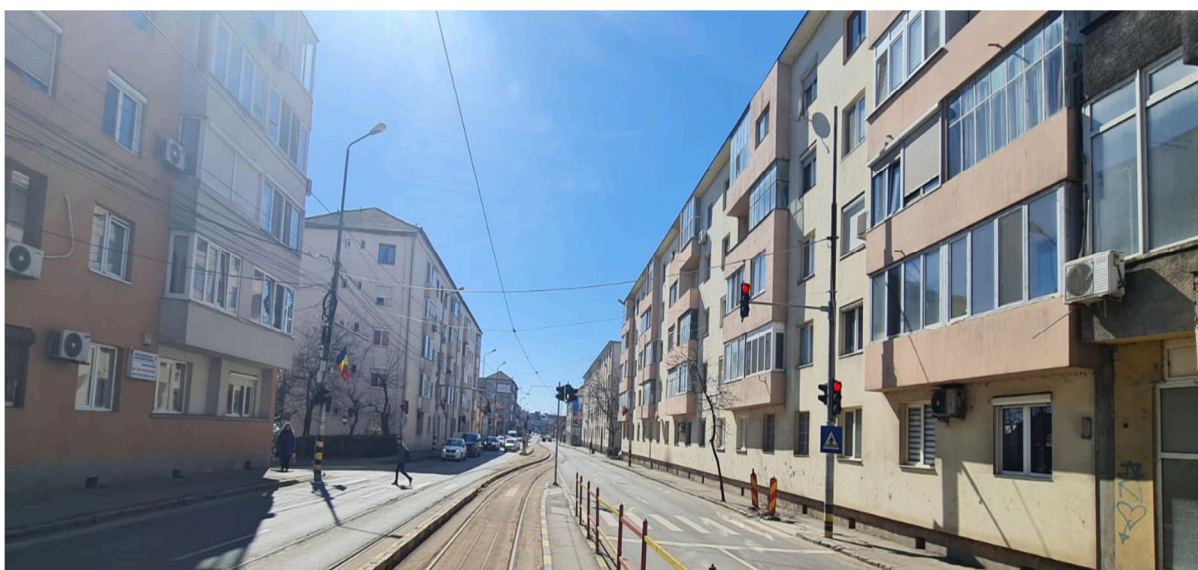
Fig.5.1 – zona 1 – Intersectia 5 - B-dul Decebal – strada Calarasilor
