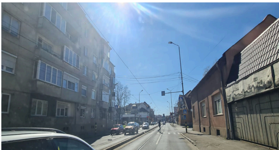
Fig.4 – zona 1 – Intersectia 4 - Trecere de pietoni cu buton pietonal – B-dul Decebal – strada Constantin Brâncoveanu
