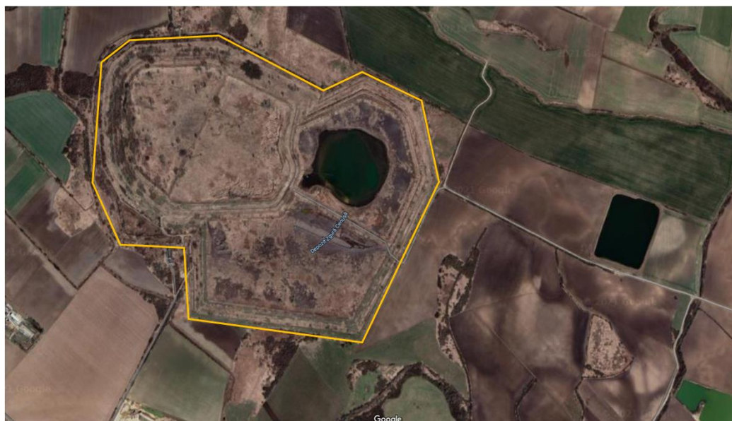
Amplasamentul depozitului de zgura si cenusa Santau Mic
