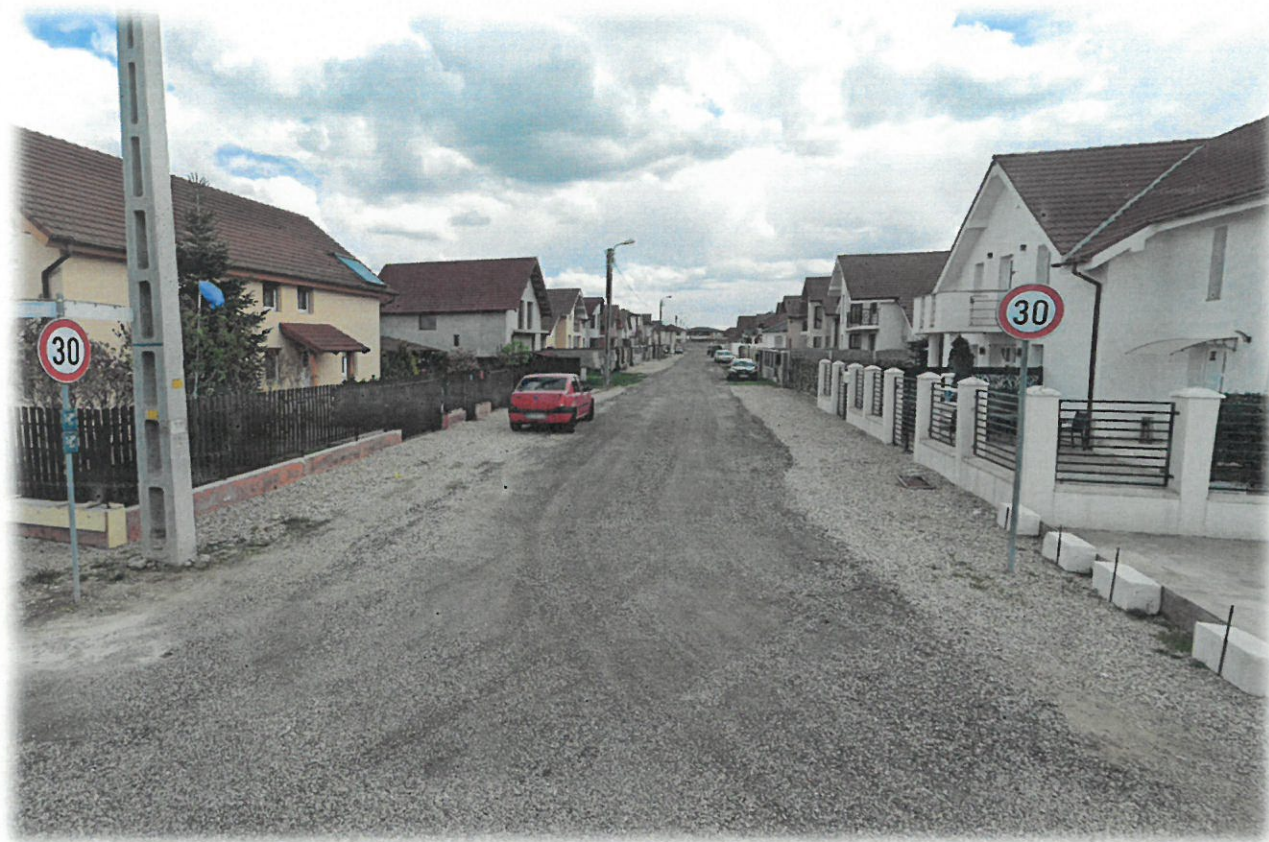
Foto 2 (Vedere din strada Radu Greceau)
