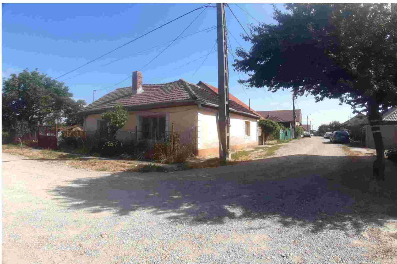
Intersecție cu strada Radautilor
