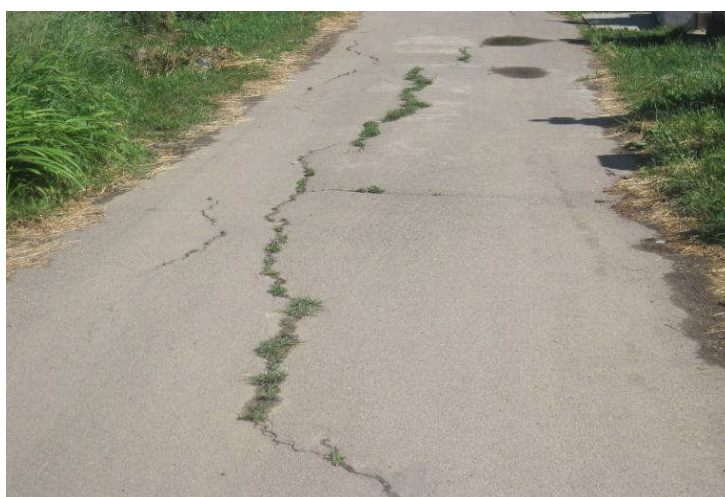
Poza 16 – vedere intersectie aleea P 109 – P119 cu aleea asfaltata existenta intre parcelele P107 – P137
