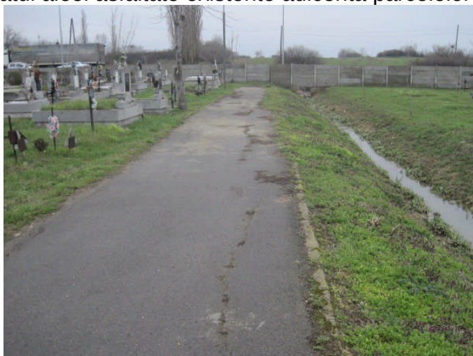
Poza 12 – vedere spre capatul aleii asfaltate existente adiacenta parcelelor P 126 – P 136
