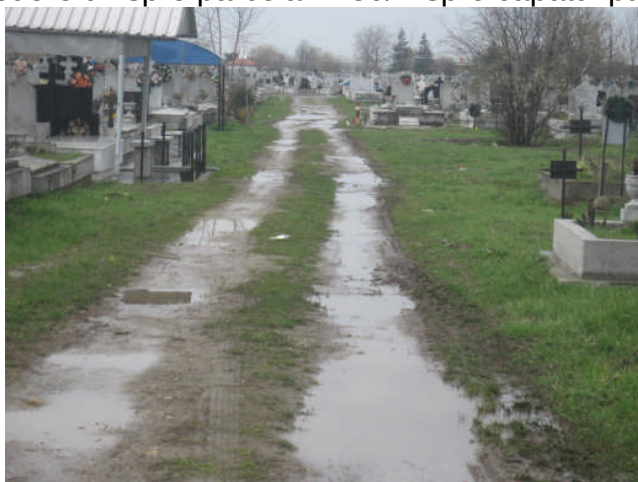
Se observa lipsa drenurilor si starea degradata a fundatiei de balast existente .
