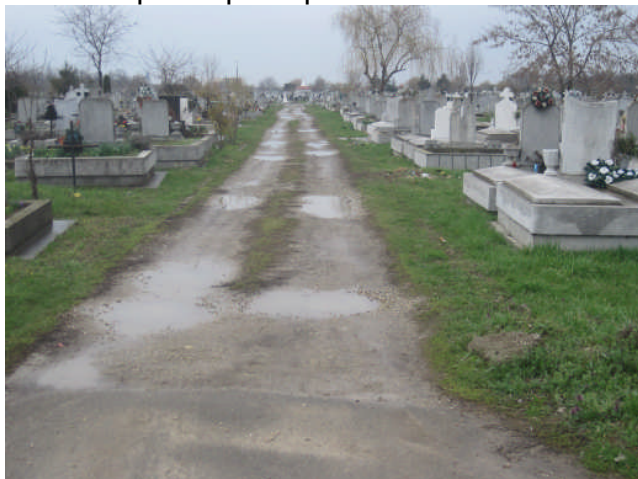
Poza 7 – vedere dinspre intersectia cu aleea asfaltata existenta intre parcelele P 133 – P 134 spre capatul parcelei P132
