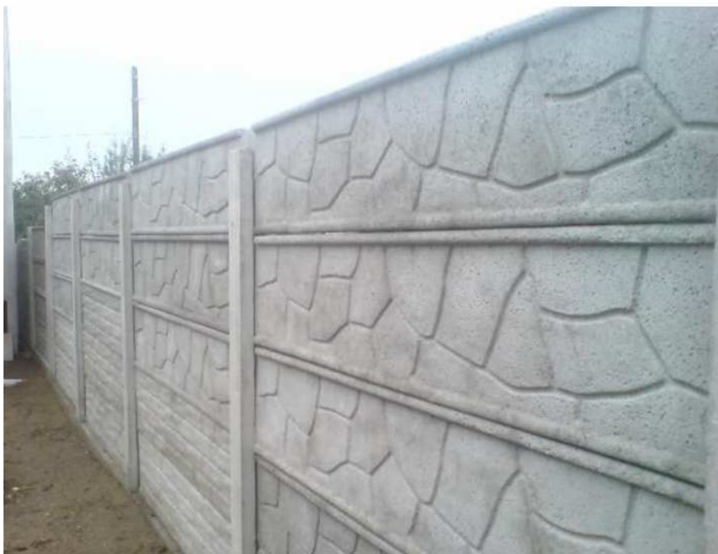
Imagine gard din beton armat
