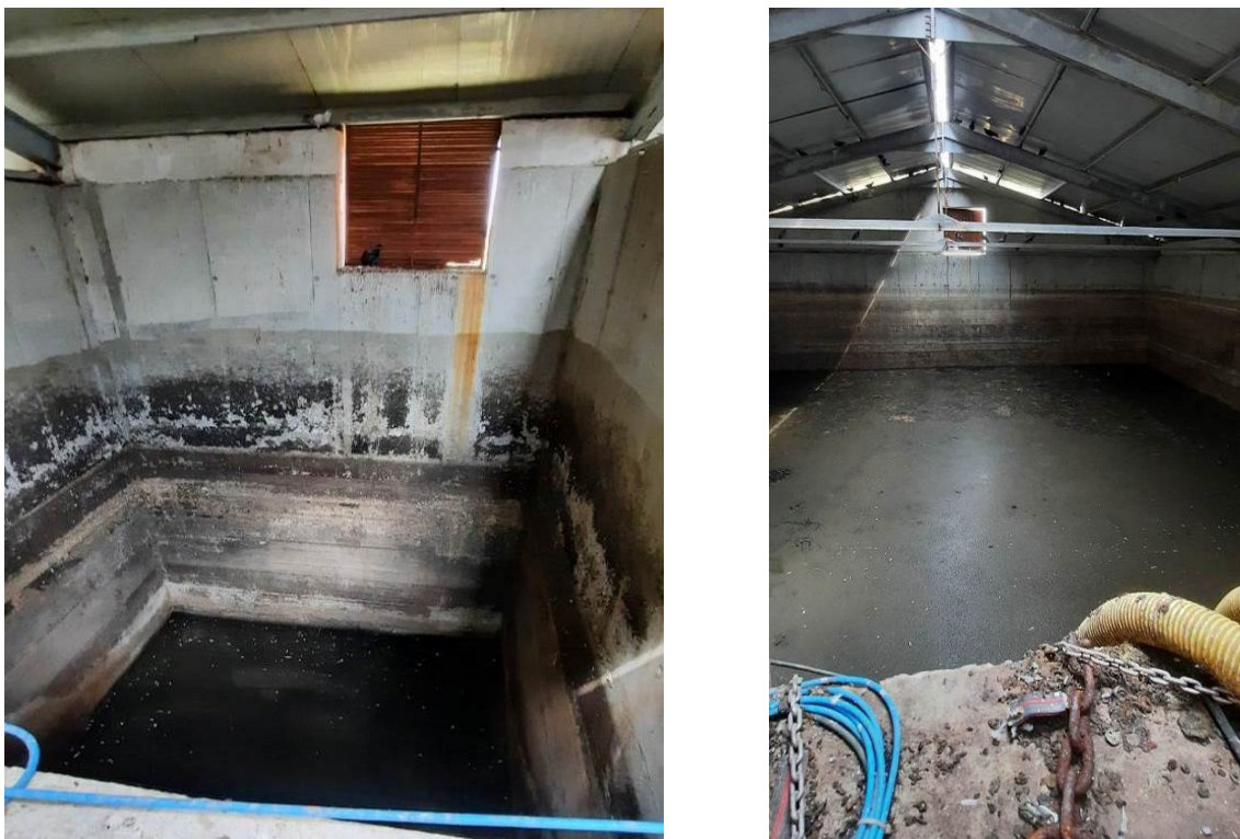
Figura 8 Bazin omogenizare și bazin biologic
