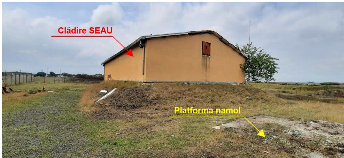
Figura 12 Clădire SEAU și platformă stocare nămol
