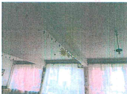
Foto nr. 1 – Structura în cadre din beton armat
