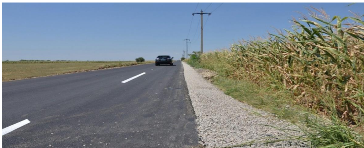
Foto: Modernizare DJ 708 Gurahonț-Buteni
