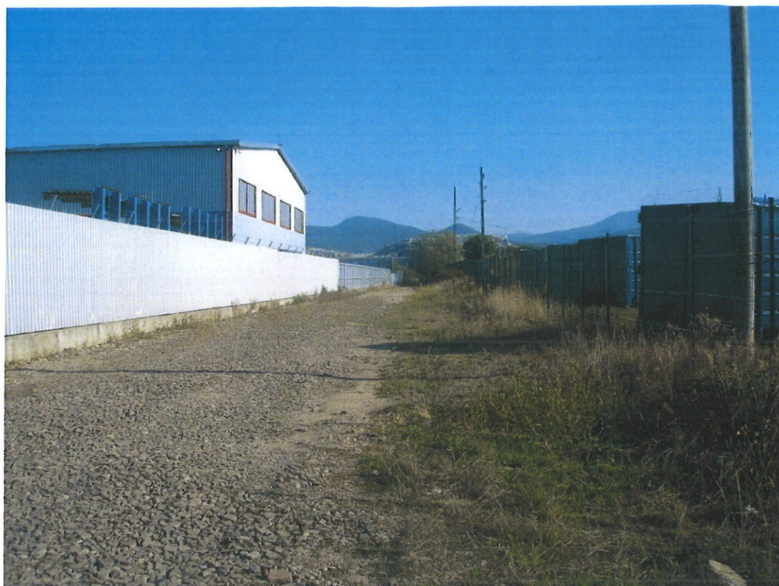
Vedere drum pietruit de acces din DJ 182B Baia Mare - Satu Nou de Jos
