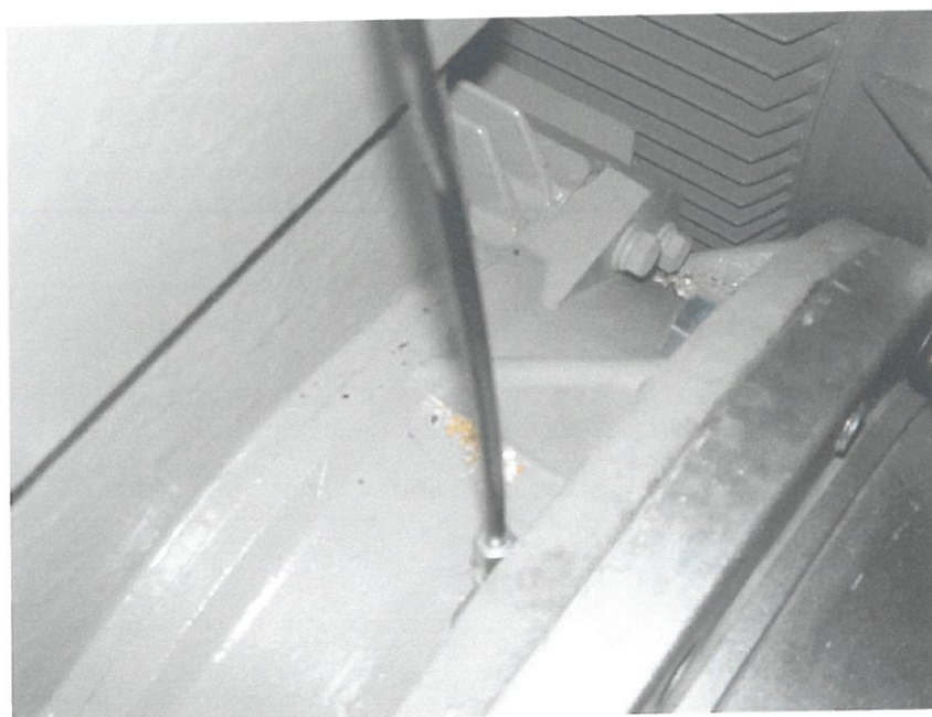
Figura 10: ungere centrală motor electric (partea cuplajului)
