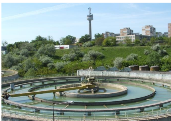
Uzina de apă nr 2-Decantor (foto3)
