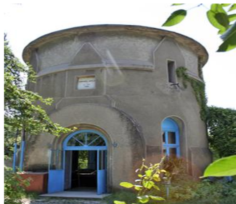
SCADA Turnul de apa (foto 8)
