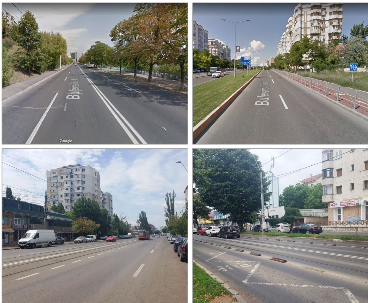
Figura 3.7. Starea tehnică a infrastructurii stradale (Exemplificare).Sursa: PMUD Galați.
