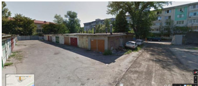
Figura 4. Amenajarea necorespunzătoare a locurilor de parcare
