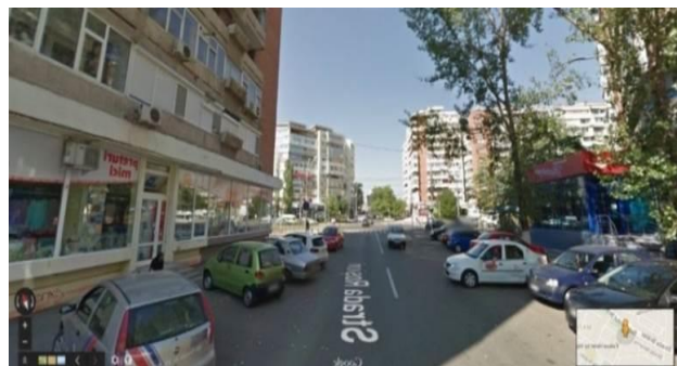
Figura 3. Amenajarea necorespunzătoare a locurilor de parcare
