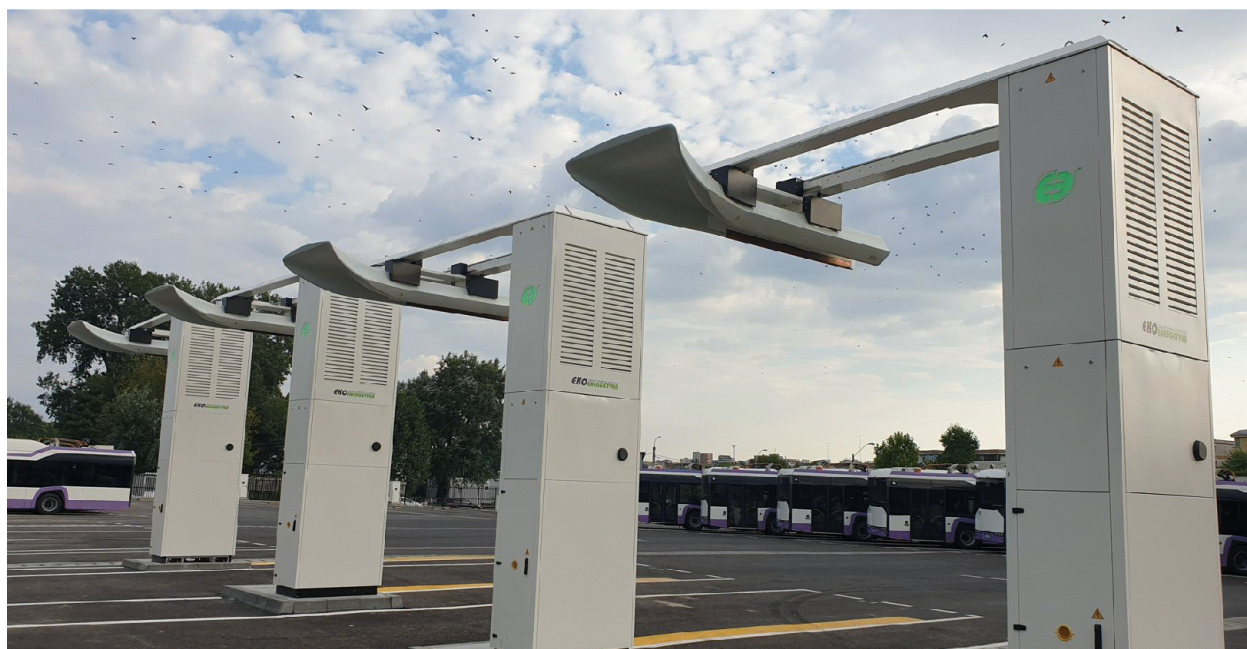
Figura 4.19. Infrastructură pentru încărcare rapidă, tip pantograph.
