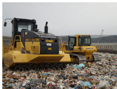
Figura 7. Utilaje în lucru pe depozit
