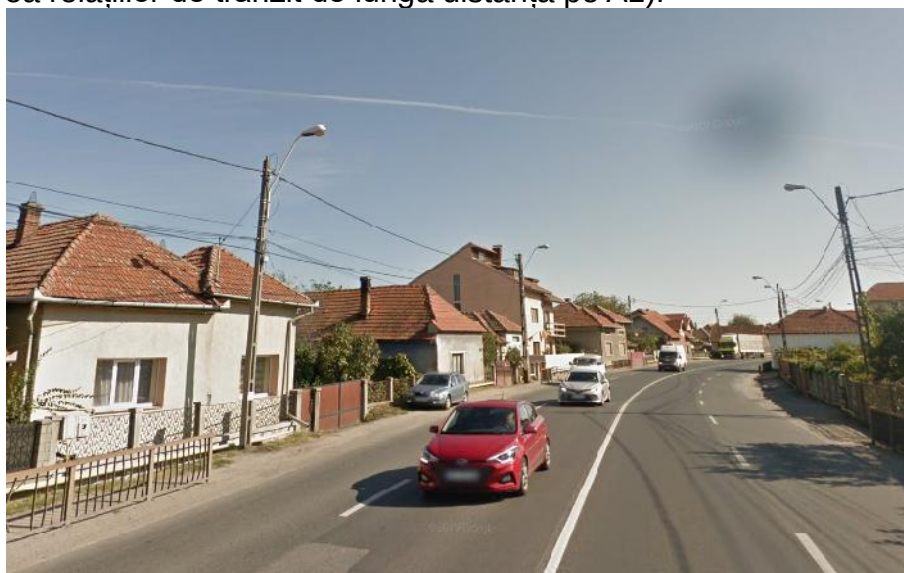
Figura 3.14. DN 7 în localitatea Sântuhalm – lipsă trotuare și dispozitive adecvate de preluare a apelor pluviale. Sursa: Google Maps.
