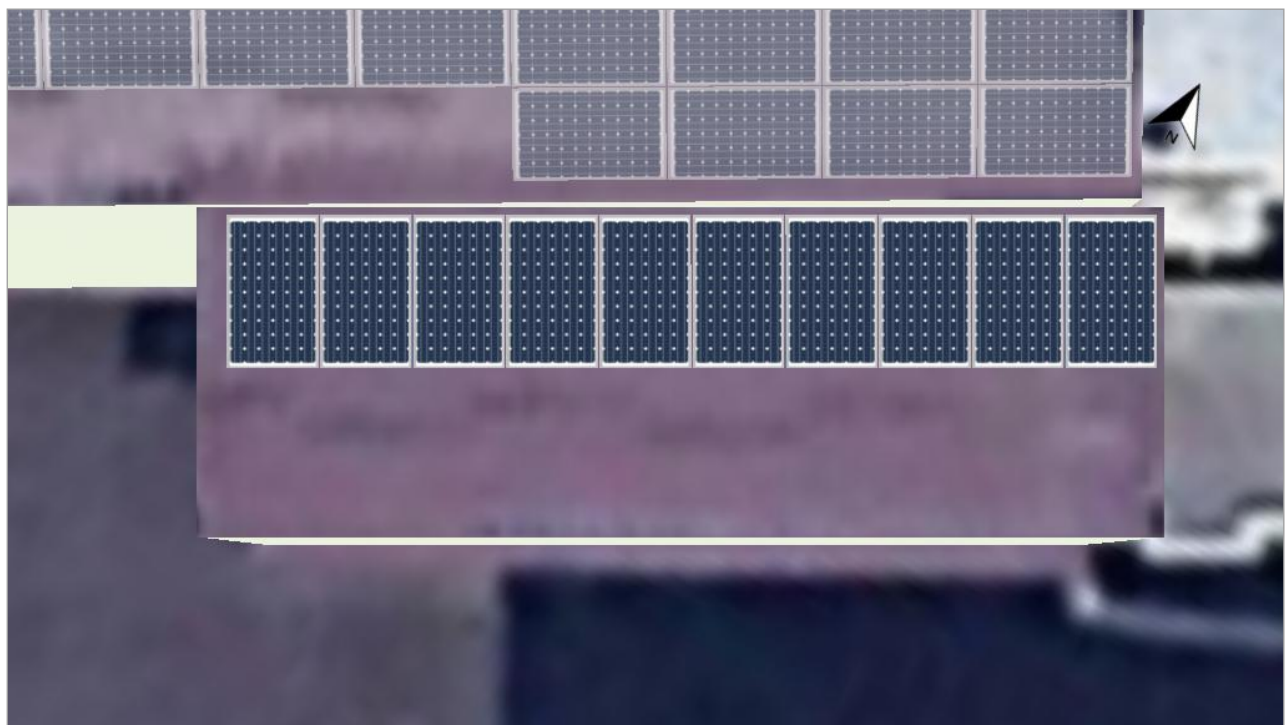
Figura: 4. Zona modulului - Building 05-Roof Area Southeast
