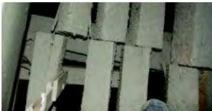
Lucrări de dulgherie în gril – nivel circulabil - deasupra unui gol de peste 15 m
