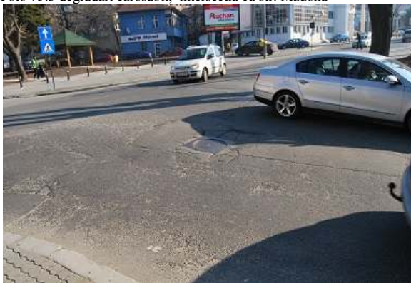
Foto 75.3 degradari carosabil, intersecţia cu str. Madona
