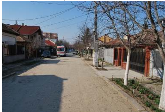
Foto 42.2 Limita carosabil piatră de râu / asfalt
