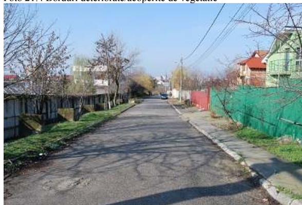
Foto 21.4 Borduri deteriorate/acoperite de vegetatie
