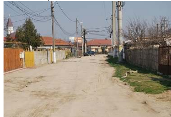
Foto 83.2 Vedere spre intersecția cu str. Maria Rosetti
