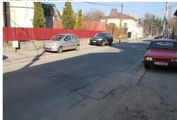
Foto 22.4 Plombe deteriorate
