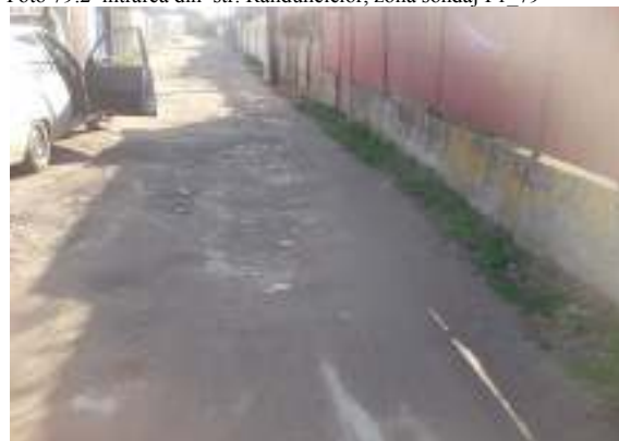
Foto 79.2 intrarea din str. Rândunelelor, zona sondaj F1_79
