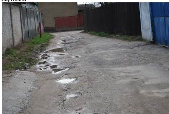
Foto 79.1 spre str. Caprioarei
