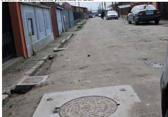
Foto89.2 Detaliu zona pietonala si dren
