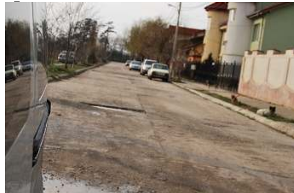
Foto 52.1 vedere dinspre str.Potelu, zona sondajului F2_52
