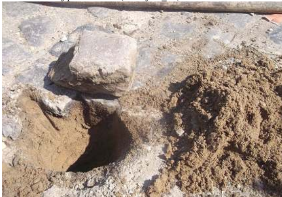
Foto 73.1. Pavaj piatră cubică (sondaj F2_73)
