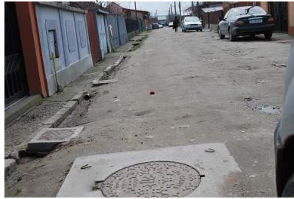
Foto89.2 Detaliu zona pietonala si dren
