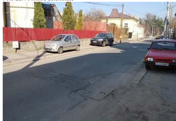
Foto 22.4 Plombe deteriorate
