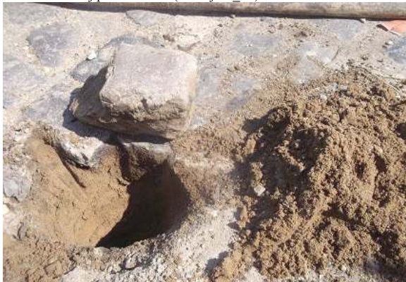
Foto 73.1. Pavaj piatră cubică (sondaj F2_73)
