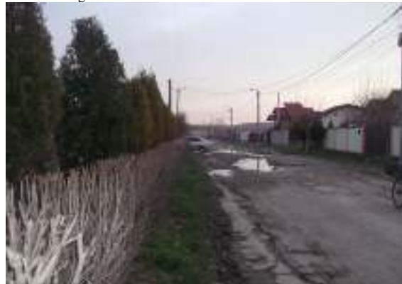
Foto 76.4 Degradari carosabil asfalt
