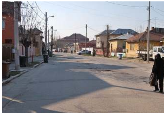
Foto 77.4 Plombe deteriorate / tasari
