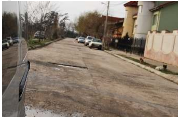
Foto 52.1 vedere dinspre str.Potelu, zona sondajului F2_52
