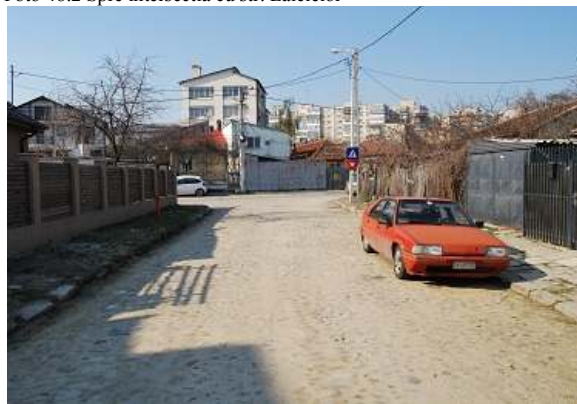
Foto 48.2 Spre intersecția cu str. Lalelelor
