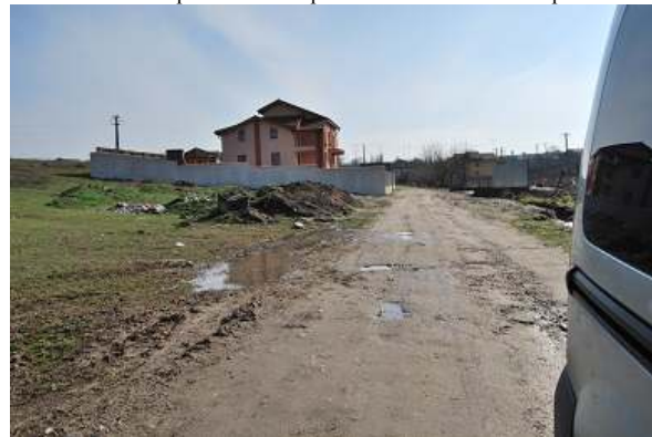
Foto 21.2 Foto asupra zonei cu suprastructura din balast compactat
