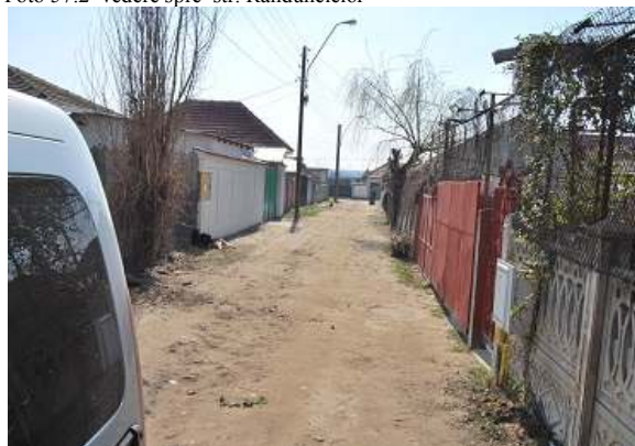
Foto 57.2 vedere spre str. Rândunelelor
