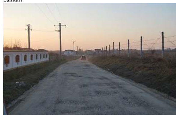
Foto 4.2 vedere spre str.Eroii Sanitari
