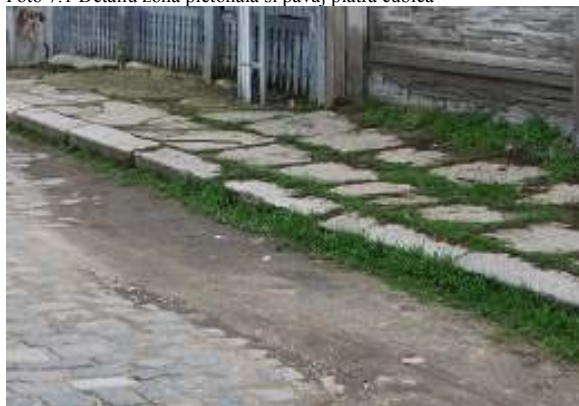
Foto 7.1 Detaliu zona pietonala si pavaj piatra cubica
