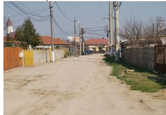
Foto 83.2 Vedere spre intersecția cu str. Maria Rosetti
