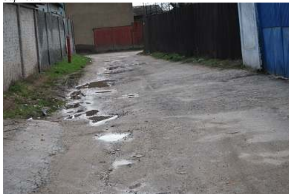
Foto 79.1 spre str. Caprioarei
