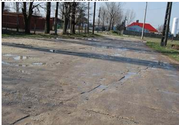
Foto 54.1 Suprastructura din placi de beton
