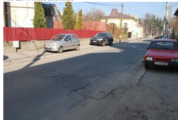
Foto 22.4 Plombe deteriorate
