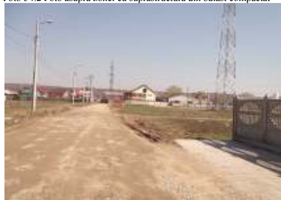
Foto 54.2 Foto asupra zonei cu suprastructura din balast compactat
