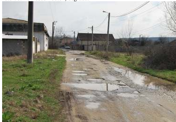
Foto 76.4 Degradari carosabil asfalt
