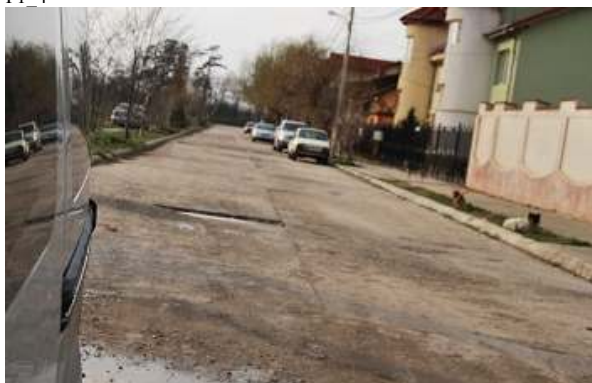
Foto 4.1 vedere spre str.Potelu, din zona sondajului FI_4
