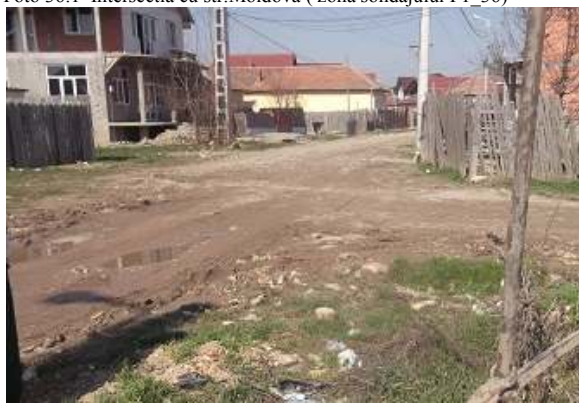
Foto 36.1 Intersecția cu str.Moldova ( zona sondajului F1_36)
