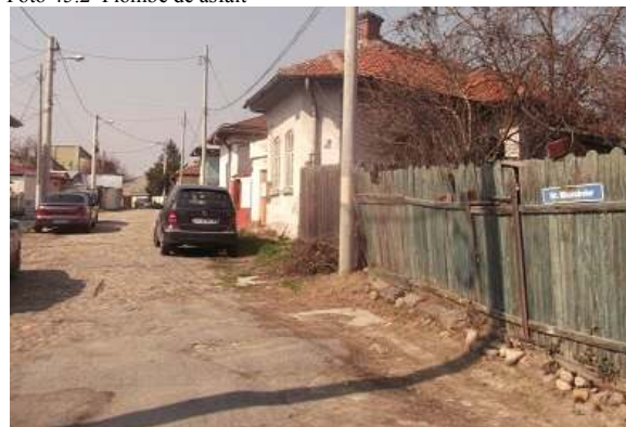
Foto 45.2 Plombe de asphalt
